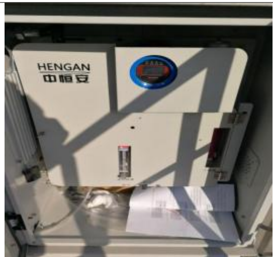
片基二部炭吸附废气治理设施排气口 (DA002) VOC 超标报警装置
