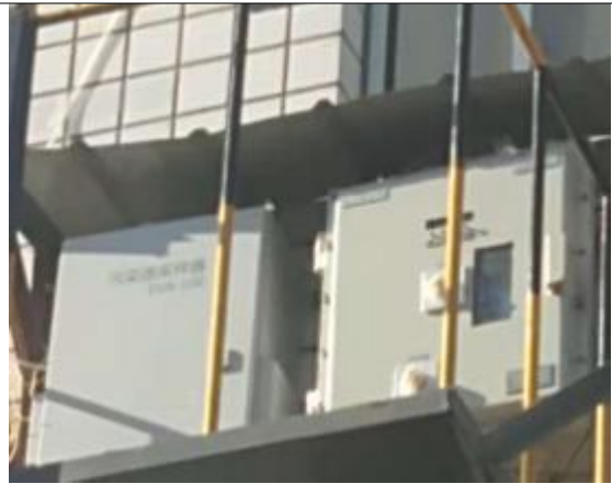
片基一部炭吸附废气治理设施排气口 (DA001) VOC 超标报警装置
