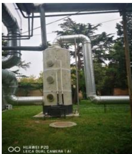
污泥脱水间废气收集
