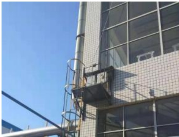
片基二部炭吸附废气治理设施排气口 (DA002) VOC 超标报警装置
