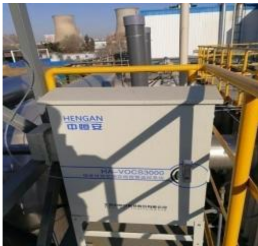
片基三部炭吸附废气治理设施排气口 (DA003) VOC 超标报警装置
