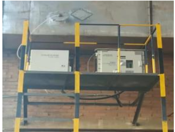
片基一部炭吸附废气治理设施排气口 (DA001) VOC 超标报警装置
