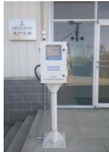
片基三部车间门口 VOC 超标报警装置
