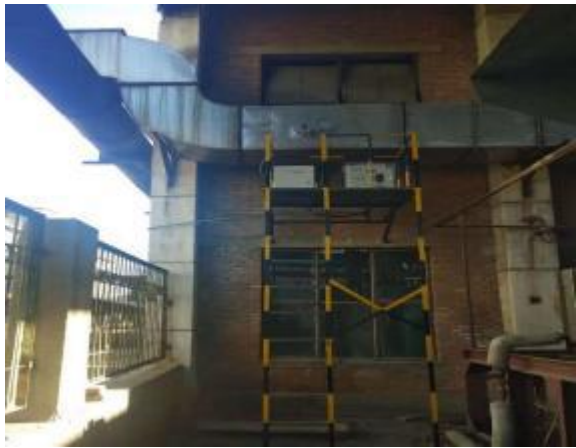
片基一部炭吸附废气治理设施排气口 (DA001) VOC 超标报警装置
