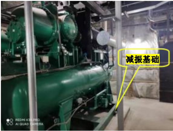
制冷机基础减振
