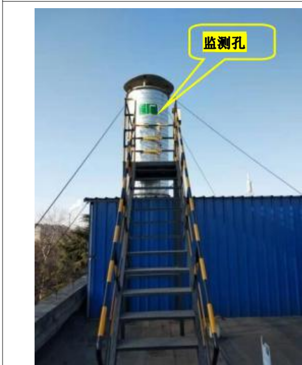
(3) 磁研楼实验有机废气排气筒 (DA007)
